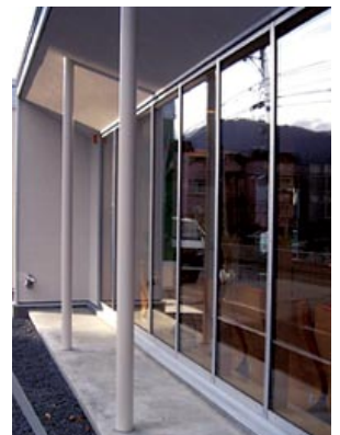
窓廻りの部分もドライウォール工法と同じ継ぎ目処理を施した
