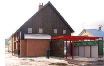
大きな三角屋根と深みのある色で塗装されたエゾマツの外装材が特徴的な外観。玄関前はカーポートと物置で豪雪と強い北・西風に対処した
