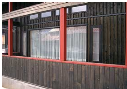
窓が小さいという倶知安の住宅のイメージを変えるため、3,500×1,600という大きな窓を南面に設置
