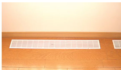
床下から暖めた新鮮外気を給気する1階床のガラリ
